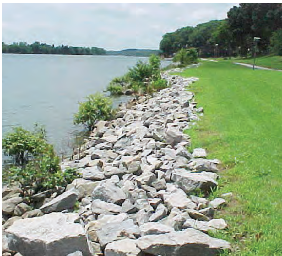
Riprap lining a lake shore
